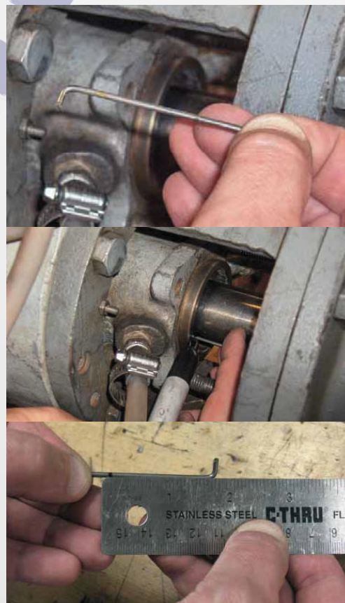
Фиг.1 Измерване на отвор за охлаждане
